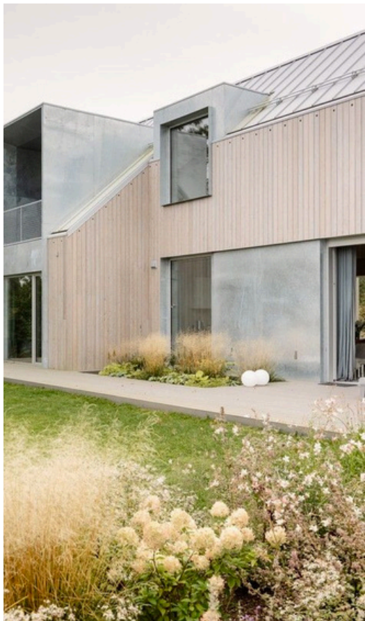
Metal Clad Dormers
